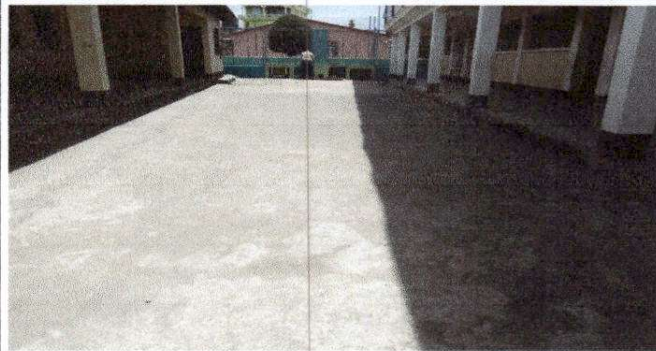
Foto 2: Reparación de planchas de concreto, de patio
